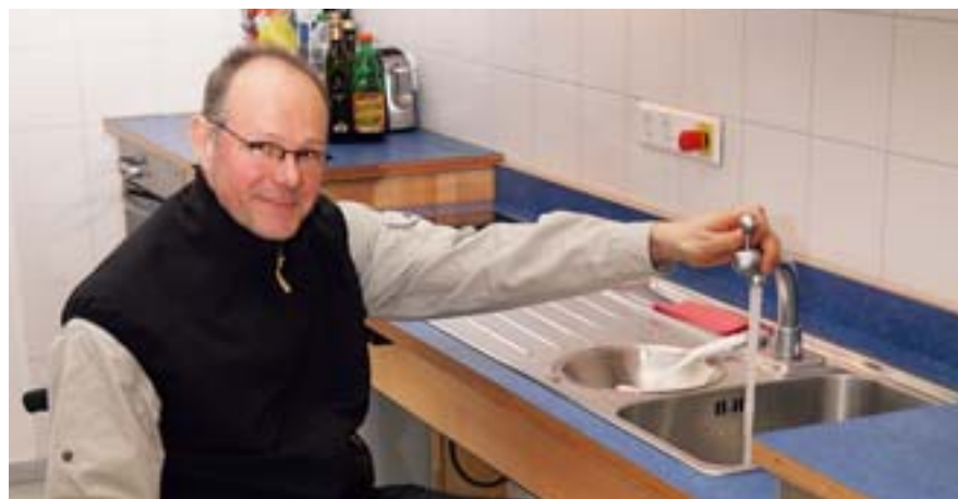
Es kommt auf die Details an: Die Einhandmischbatterie wird leicht erreichbar über einen Hebel am Brausenkopf bedient
